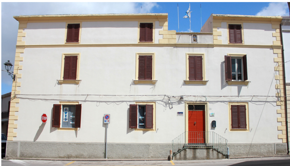
Prospetto principale Casa Sanna
