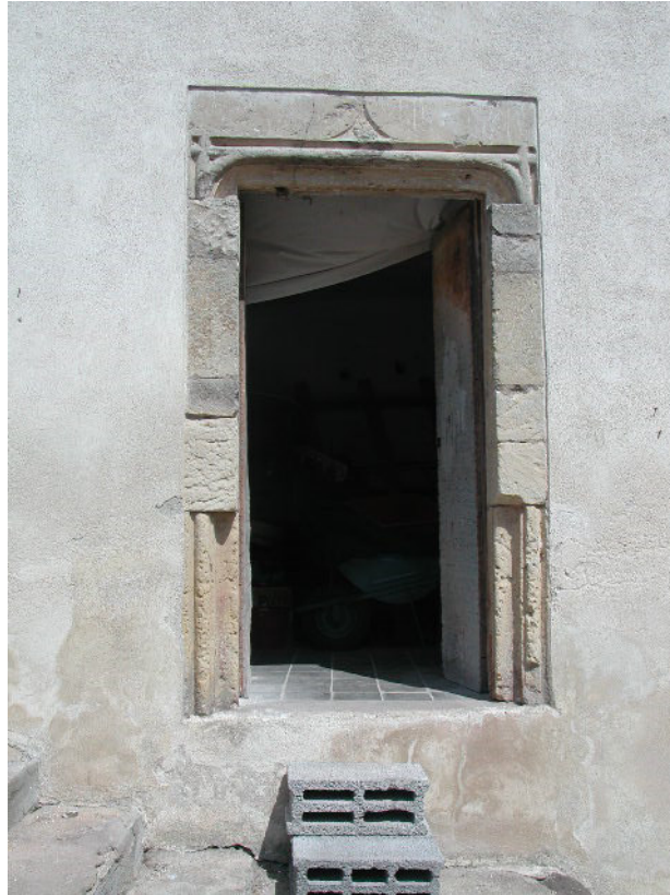
Lato destro presso la chiesa San Giorgio, architrave e stipiti con motivo geometrico in rilievo e arco inflesso con rosetta.
